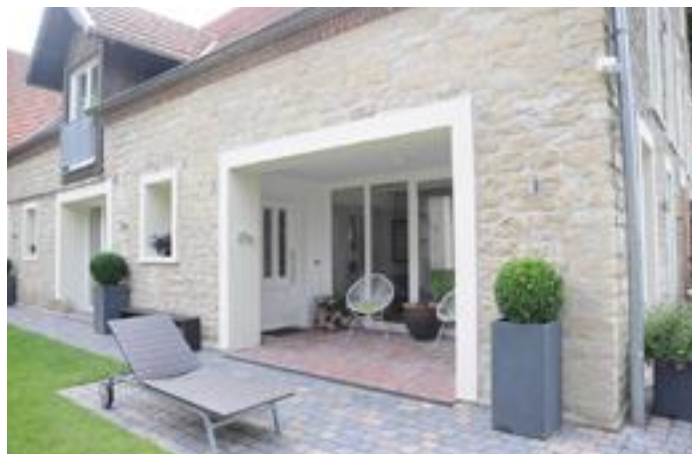
Durchdachtes Detail: Die Eingänge zu den Wohnungen springen zurück, sodass jeweils ein überdachter Freisitz entstanden ist.
